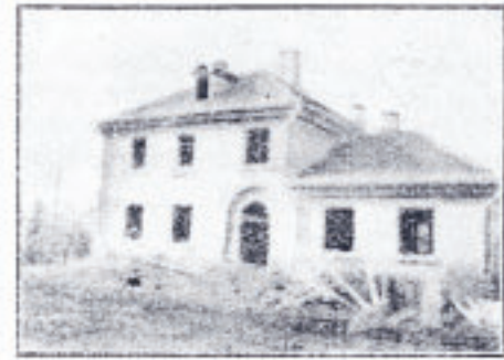
Jeden ze znajdujących się obecnie w trakcie budowy budynków — dla posterunku P. P. w Ostkach, woj. poleskie (typ zasadniczy — z pomieszczeniem dla 4 skoszarowanych)!
