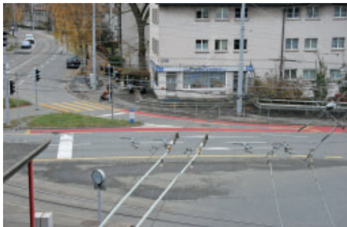
Droga dla rowerów przed skrzyżowaniem jest pomalowana na czerwono. Zwraca uwagę kierowców samochodów na bezpieczeństwo rowerzystów
