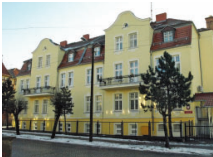
Budynek KP w Sulechowie z początku XX w. przeszedł kompleksowy remont w latach 2004–2008
