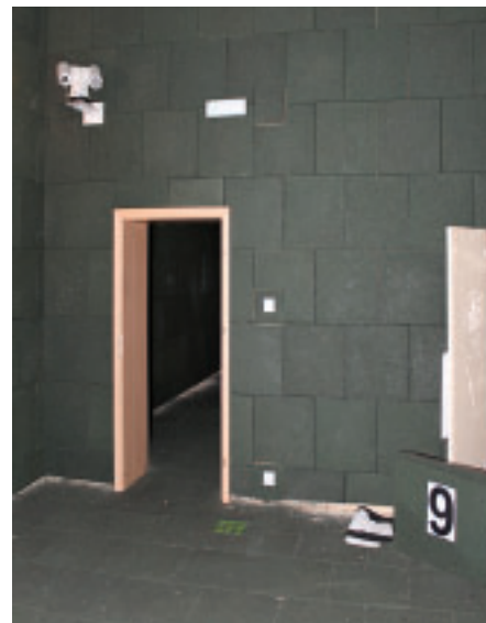
Jedno z pomieszczeń strzelnicy taktycznej
