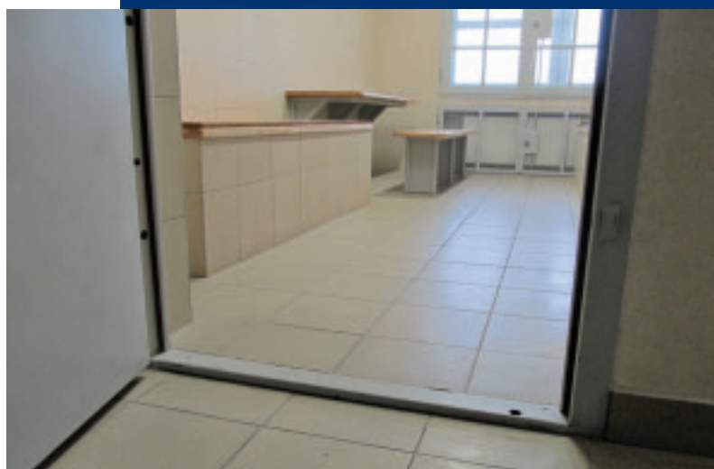
KRP Warszawa VI – nowy pdoz przystosowany dla niepełnosprawnych (np. ma niskie progi)
