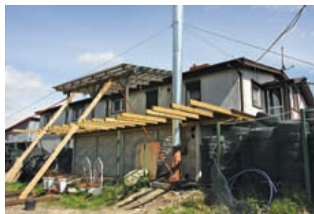
Trwają prace remontowe budynku, w którym wybuchł pożar
