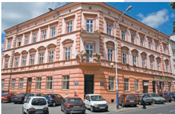
W tym domu, kilka kroków od rynku, na parterze ma powstać Muzeum Dobranocek (pierwsze trzy okna po prawej i lewej stronie od głównego wejścia)
